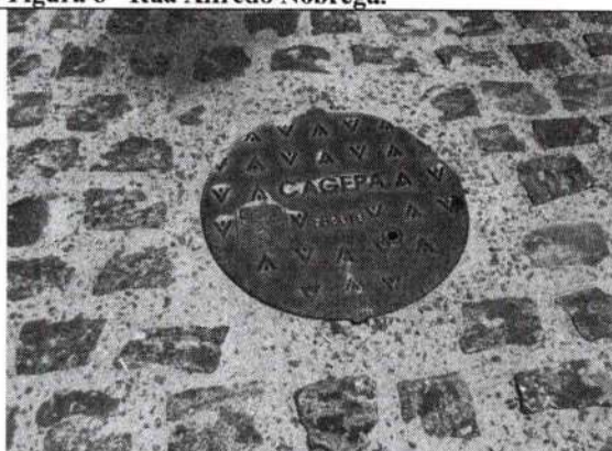
Figura 8 – Tampas de Poço de Visita.
